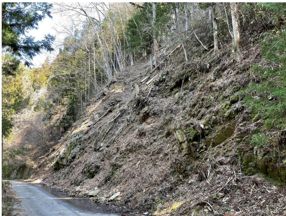
○令和 3 年度 法面改良 【施工前】
